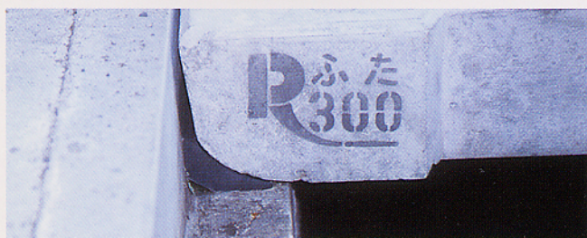
⑤ 側溝用防音スペーサをしっかりと接着する。 10分程度静置してリボン蓋を掛け蓋の自重により側溝用防音スペーサを押さえる。
