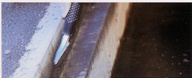
① 側溝用防音スペーサを準備する。
