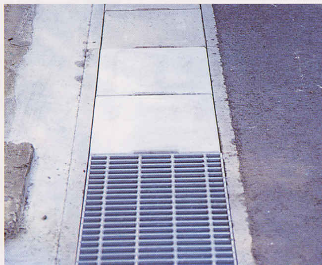
⑥ 施工完了 施工後1日程度、車が通らない様に養生をして道路を開放する。
